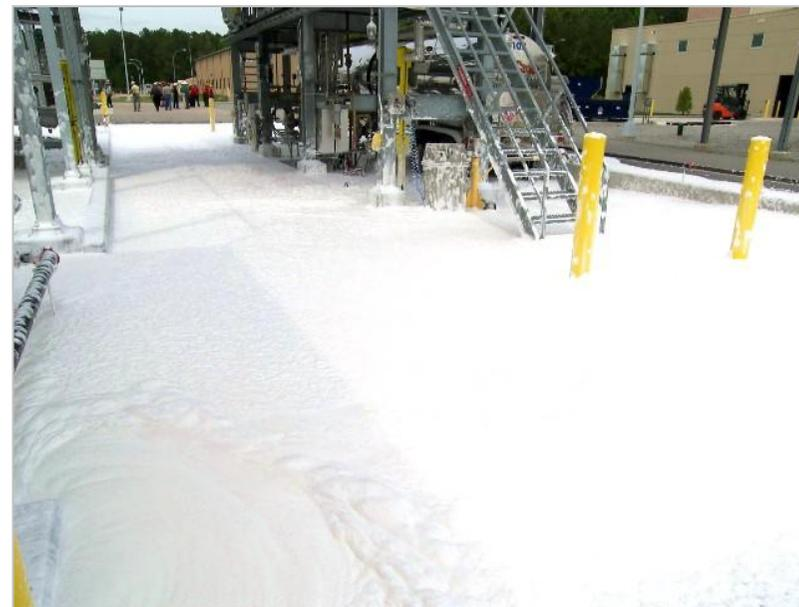
Работа осциллирующих оросителей (пенных стволов), обеспечивающих подачу пены и ее равномерное распределение по углу и по дальности
