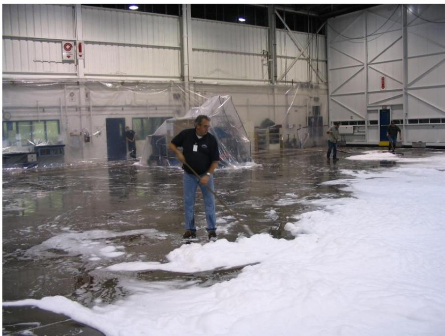
Уборка компрессионной пены после срабатывания установки
