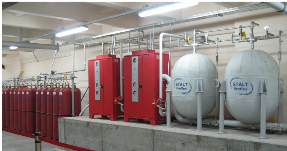
Установка пенного пожаротушения с генерированием воздушно-механической пены компрессионным способом (компрессионной пены), с запасом сжатого воздуха (азота) и пенообразователя, выполненная на базе оборудования ГК «СТАЛТ»
