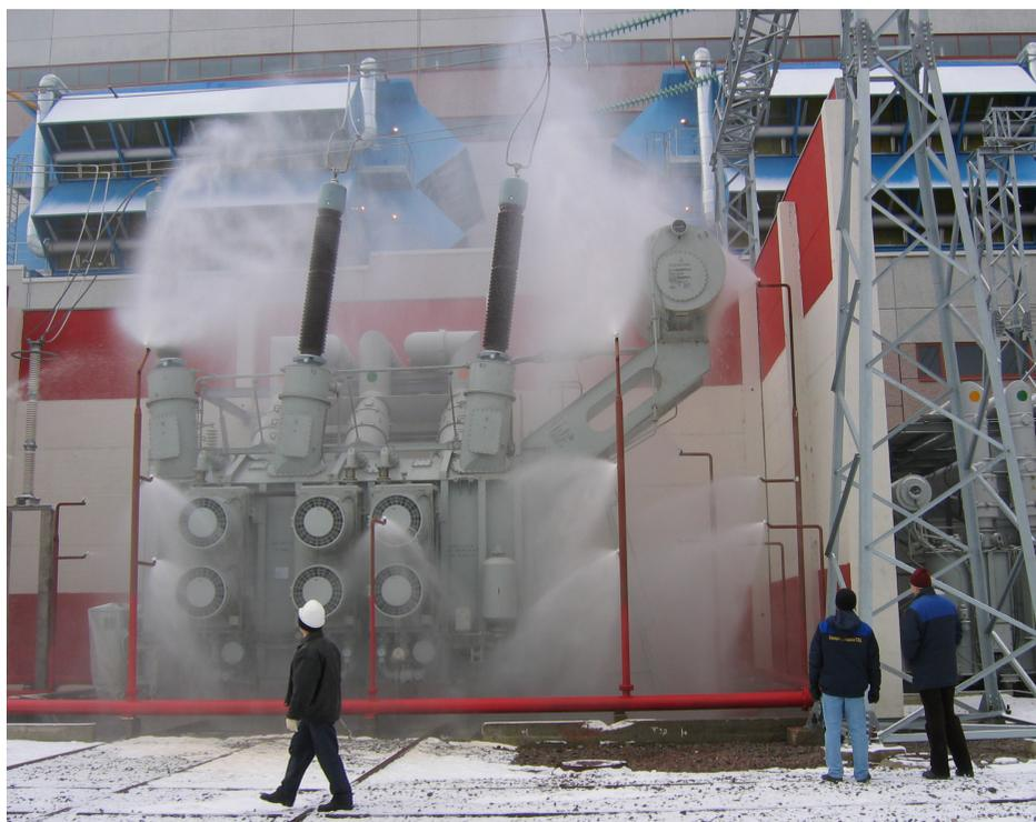
Пробный пуск системы пожаротушения трансформатора
